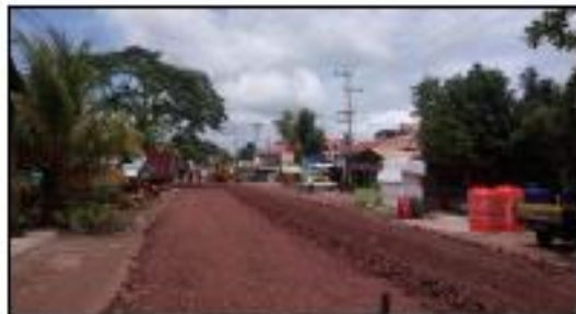
Perbaikan Jalan Umum
